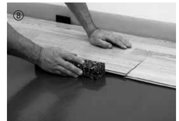
Bei Bedarf mit Schlagklotz leicht nachklopfen.
