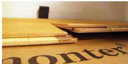
Ab der zweiten Reihe werden die Dielen längsseitig in einem Winkel von 30° in die Nut der vorigen Reihe gelegt und anschließend nach unten geklappt. Der Versatz zwischen Stirnstößen benachbarter Reihen muss mind. 30 cm betragen.
